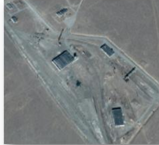
Барилга байгууламж Багануурын уурхайн цахилгаан зүтгүүрт хөрс тээвэрлэлтийн станцын барилга байгууламжууд /одоогоор ашиглалтгүй/
