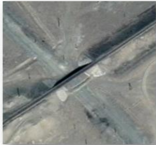
Төмөр замын туннель Багануурын нүүрсний уурхайлалтын хөрсний алсын овоолгын цахилгаан зүтгүүрт төмөр замын Багануур Багахангайн магистрал төмөр замын доогуурх гарц
