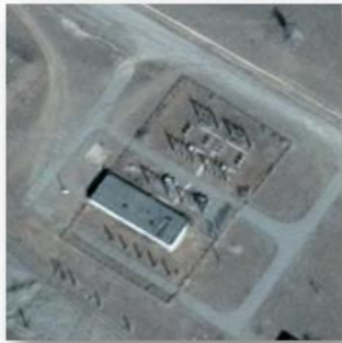
Галуут дэд станц Багануур ХК-ны ашиглалтын талбайд байрлах 110/35/6кВ-ийн хүчдэлтэй 2х6300кВА чадалтай трансформатартай дэд станц
